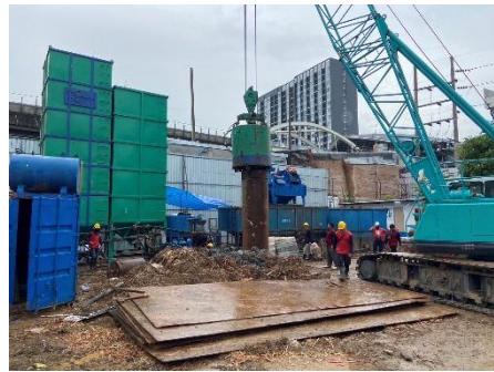
รูปที่ 21 ใช้เสาเข็มแบบเปียก
