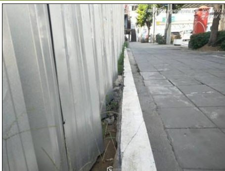
รูปที่ 37 Curb Concrete
