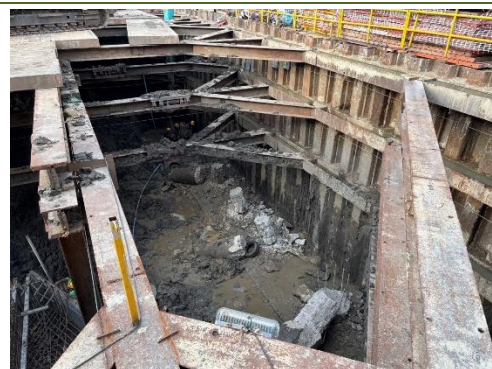
รูปที่ 25 Sheet Pile
